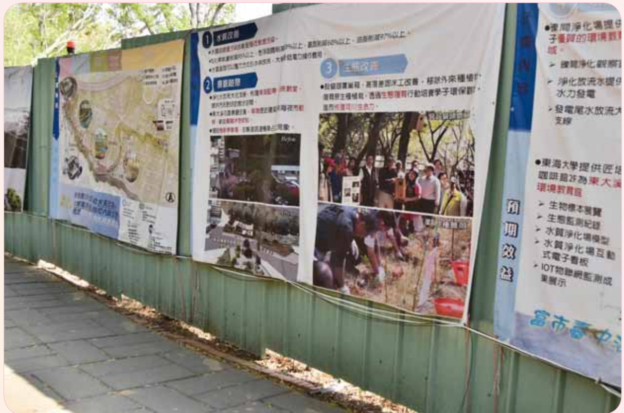
圖十一：「東大溪水環境及鄰近區域環境改善計畫」工程設施圍籬和說明海報
