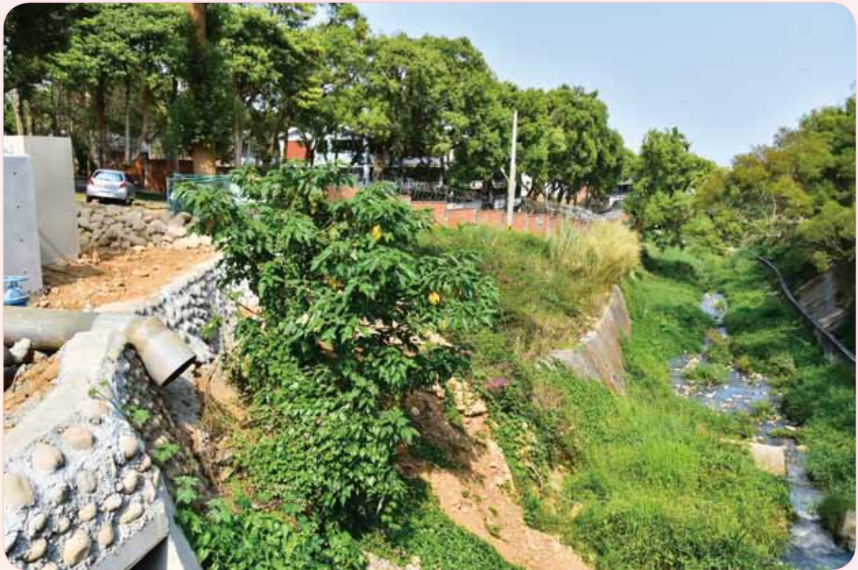
圖四：東大溪沿岸概況
